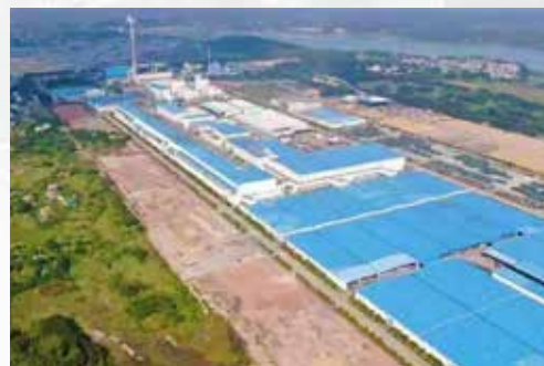
金桂二期年产 180 万吨高档纸板扩建项目已开工
