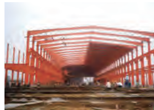
图为金东纸业（江苏）股份有限公司施工现场
