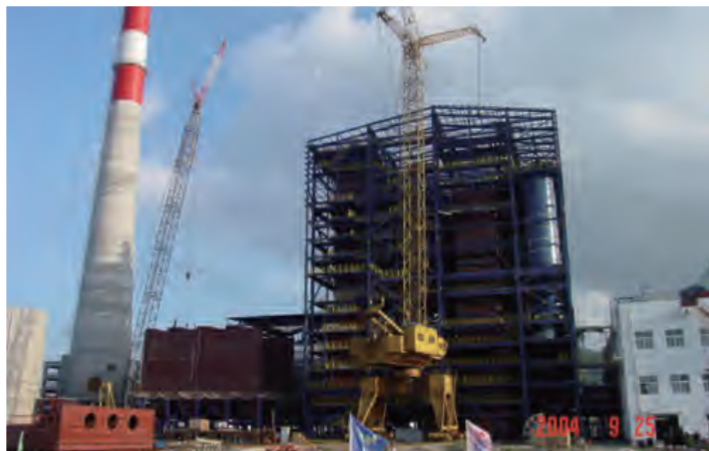
2004年09月25日宁波亚洲浆纸业300吨CFB锅炉安装塔吊现场
